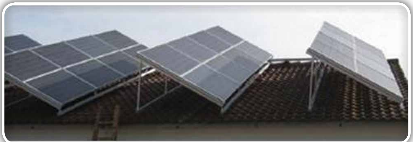
Slika 12: Primer montaže in izgub zaradi »lastne sence«
