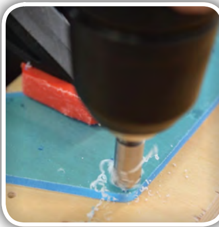
Slika 16: Vrtanje montažnih lukenj
