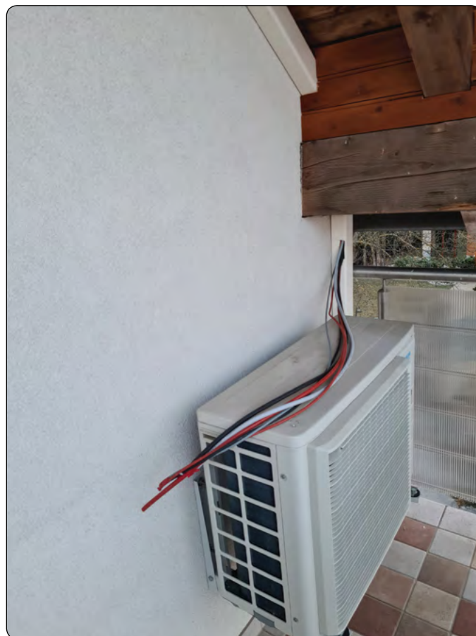
Vse kable sem pripeljal na mesto montaže inverterja. Vir: avtor
