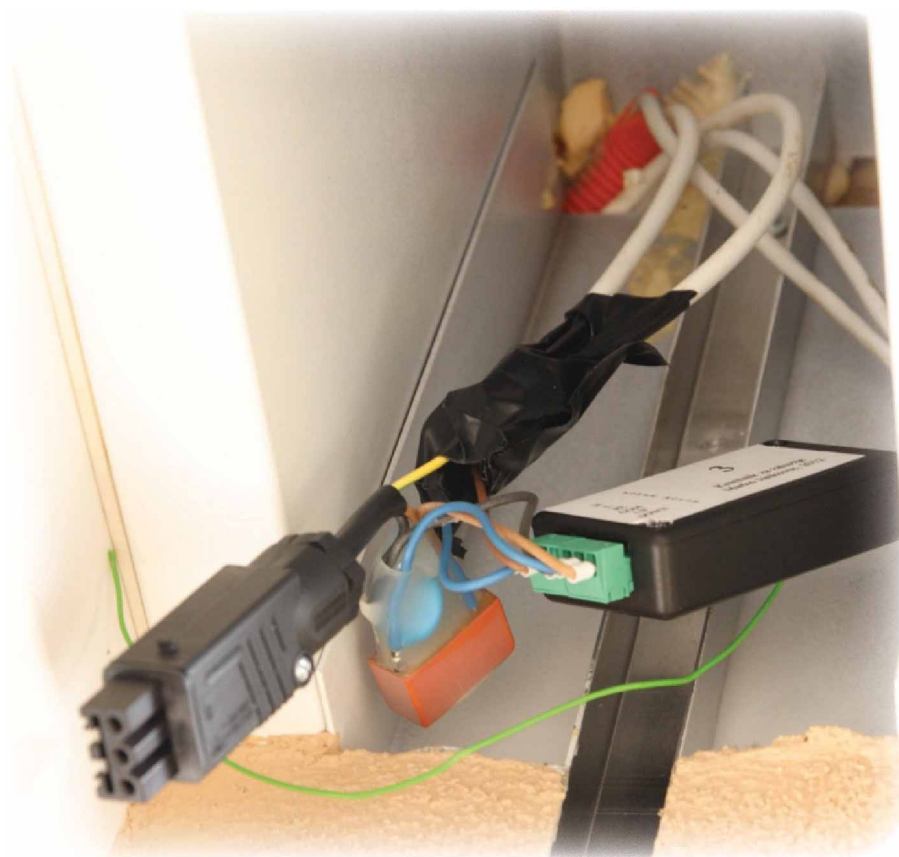
Slika 6: Krmilnik z zunanjim relejem, pripravljen za priklop na motor v škatli za žaluzije
